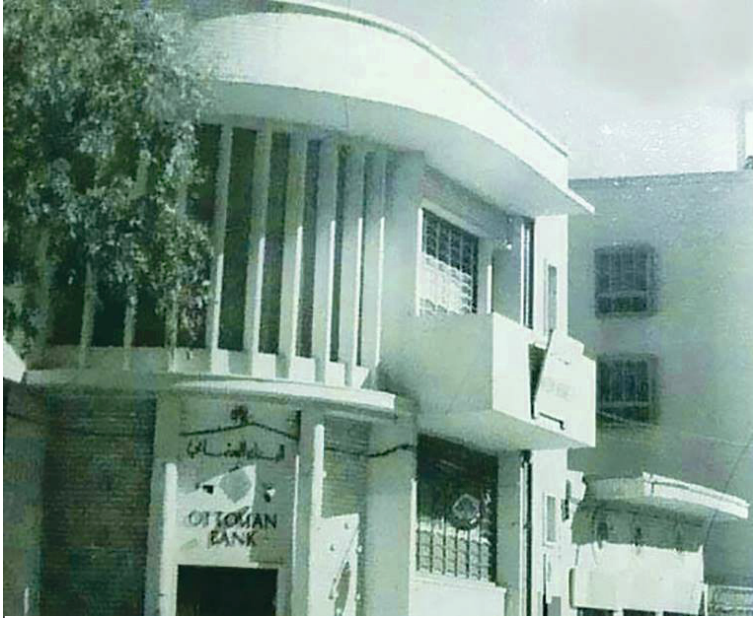
مبنى المصرف العثماني بمدخل شارع الوطني
